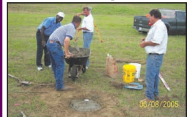
Crew pouring benchmarks
