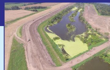
Item 462L: Levee Enlargement & Berms Project
