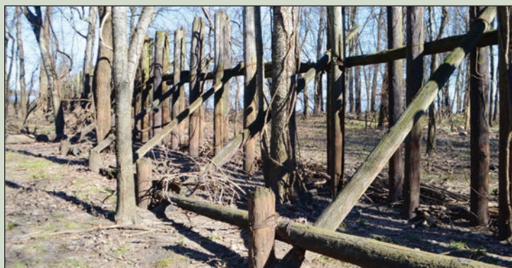
Old Timber Pile Dike at Sta. 470
